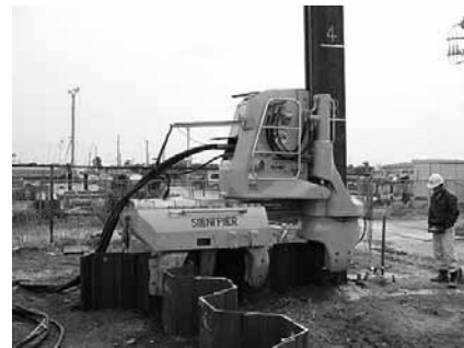
写真5 圧入工法による打設 Photo 5 Installation by silent pier
