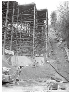
写真7 施工現場状況
