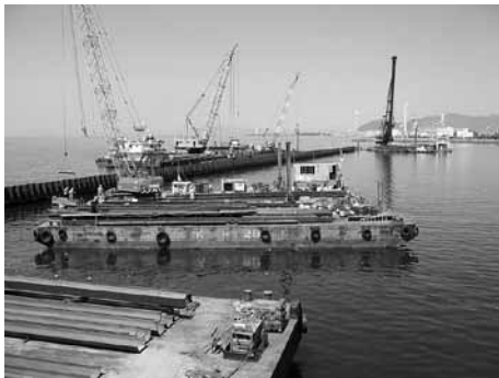
写真6 Jポケットパイル ® の打設
